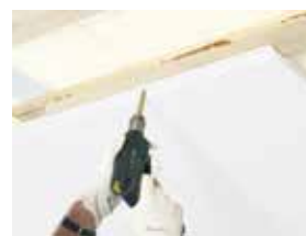
Fijación mecánica de las placas Focus F
