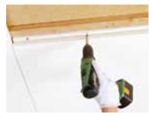
Master F se instala con fijación mecánica
