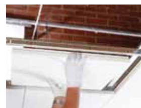
Los paneles individuales se desmontan con facilidad
